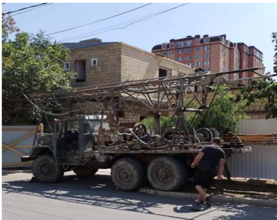
Фоторегистрация буровых работ
